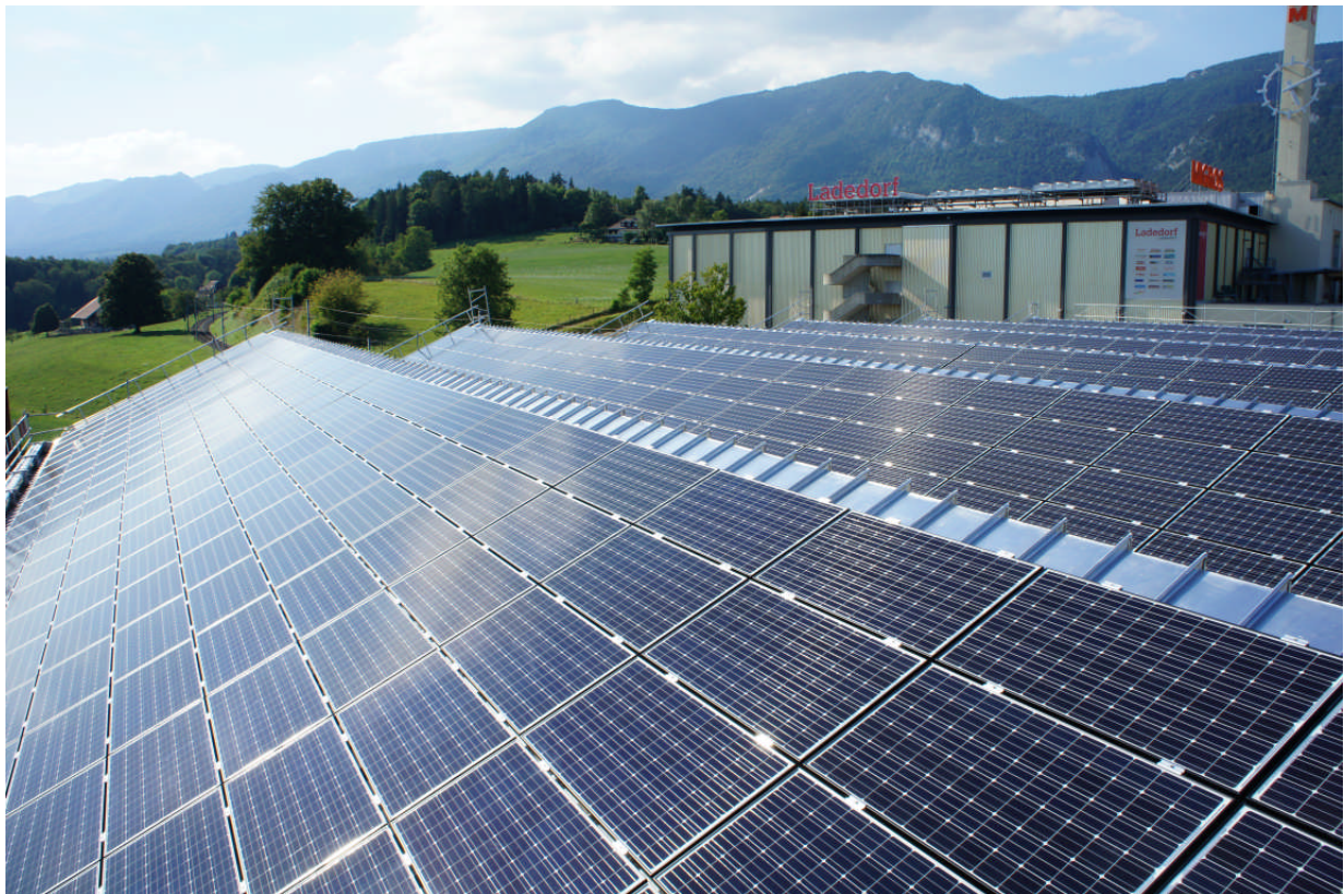
Figure 2: Fertig gestellte Dachfläche
