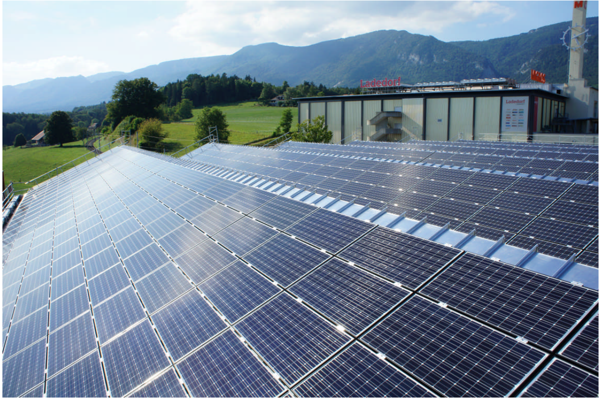
Figure 2: 完成後の屋根の表面
