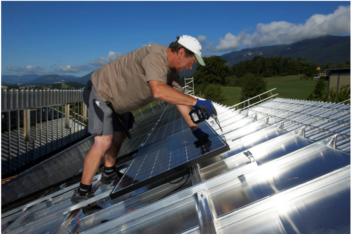
Figure 1: スイスのトルニンガーAG工場屋根の据付工事
